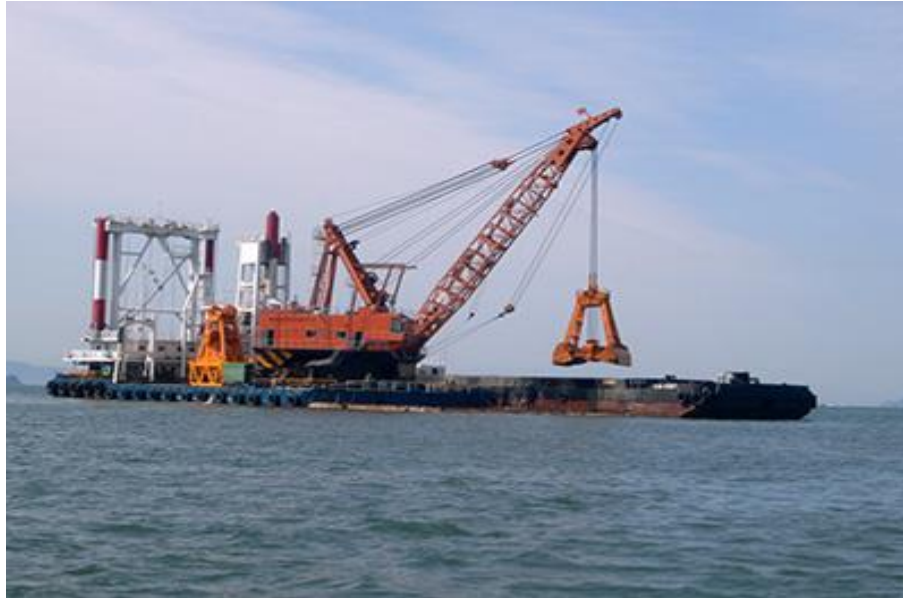
Figura 10. Demonstração do uso de grua para transferir carga
