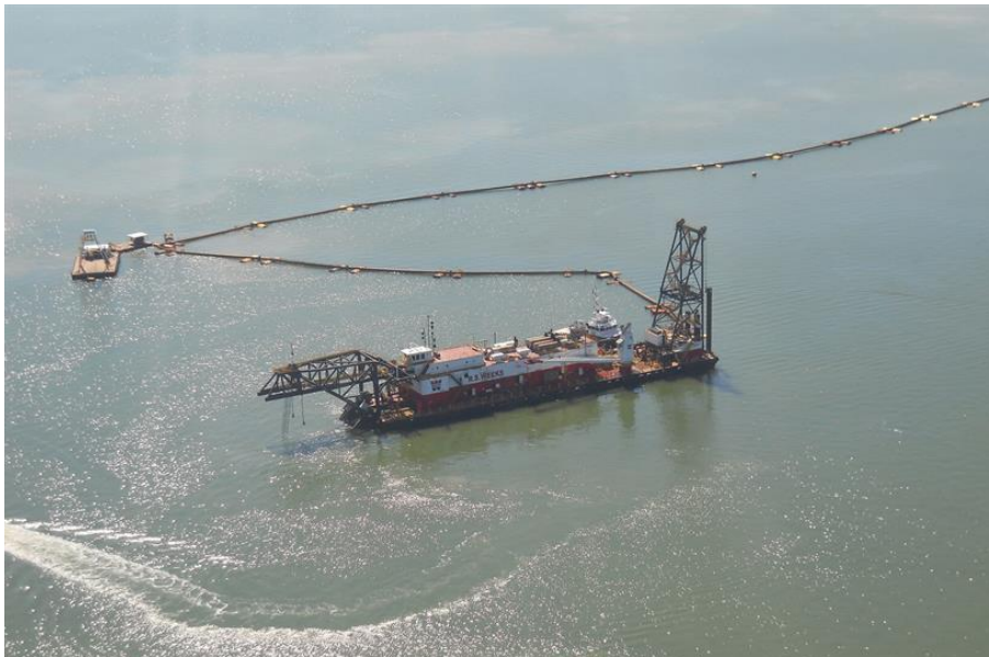
Figura 9. Demonstração do uso de tubagens para transferir carga
